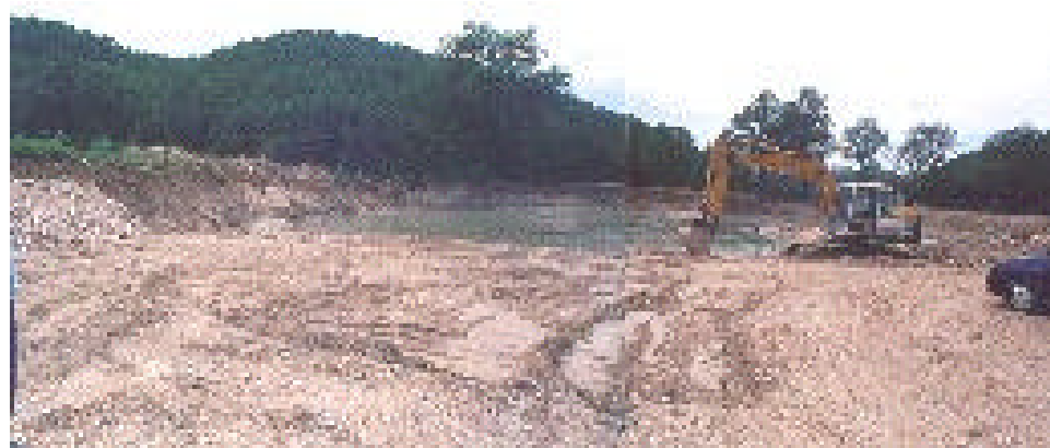
n. 90 Id. Cava 52 373 Todi Ponte Naia (8/7/2001)
