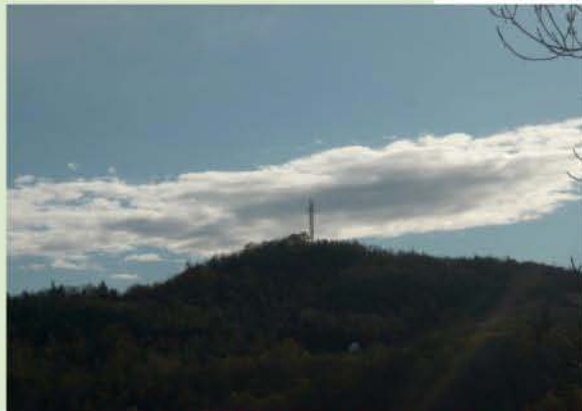
STATO ATTUALE: VISTA DALLA STRADA PROVINCIALE n. 63 ALBINEA-CASINA
