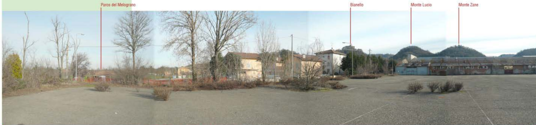
Panoramica dell'area Ex Fornace da levante (sx) verso sud (dx)
