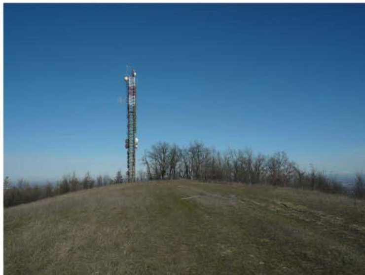
STATO ATTUALE: VISTA RAVVICINATA DA EST
