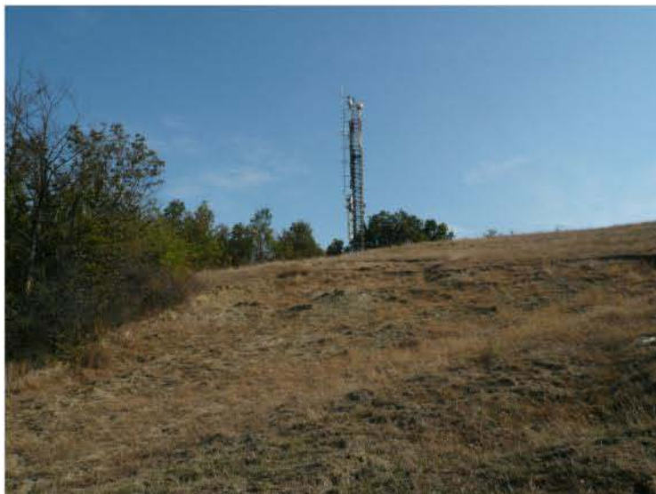
STATO ATTUALE: VISTA RAVVICINATA DA NORD-OVEST
