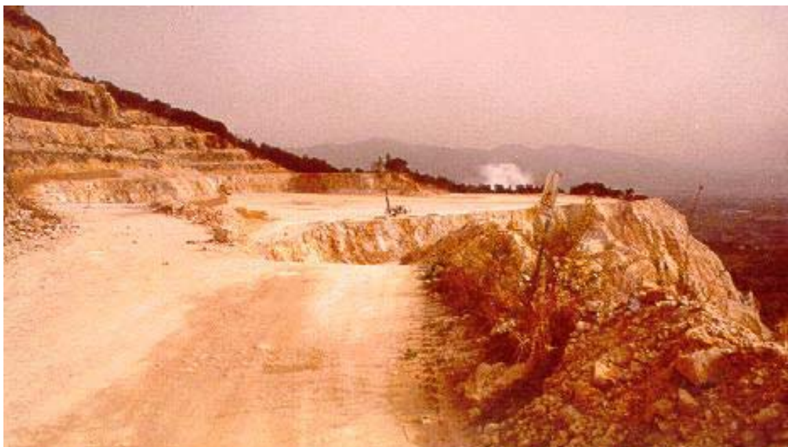
Figura 5: Cava a splateamento su gradone unico – caso reale
